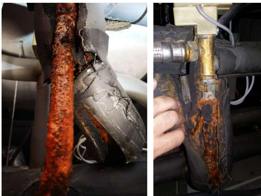
*Foto 2 – 3 Detalle estado tuberías*
